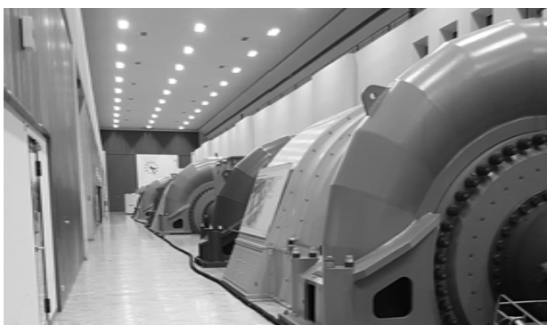
Tief im Felsinnern unter dem Grimselstausee treiben drei Turbinen die Generatoren an.
